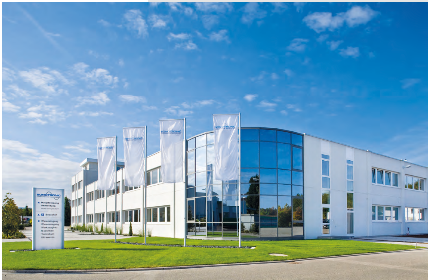
Abb. 1 – Hauptsitz des Unternehmens Sonotronic in Karlsbad Fig. 1 – Sonotronic headquarters, Karlsbad
